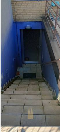
KG Kellerabgang Terrasse, Gaußstr. 21, 50767 Köln
