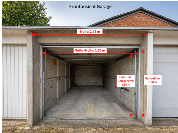
Irisweg Garage Außen + Maße, 50767 Köln.
